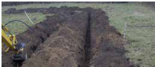
Figur 6.1. Etablering af vandrette jordslanger
