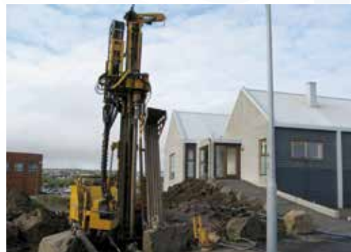
Figur 6.6. Etablering af lodrette borer.
