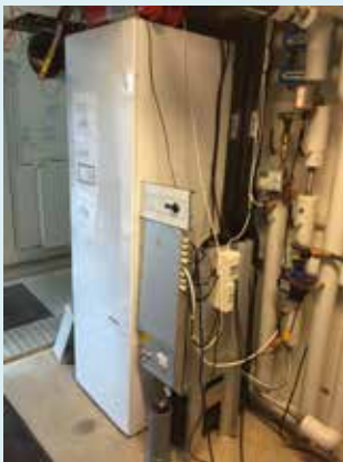
Figur 5.12. Væske/vand varmepumpe med vandrette jordslanger.
